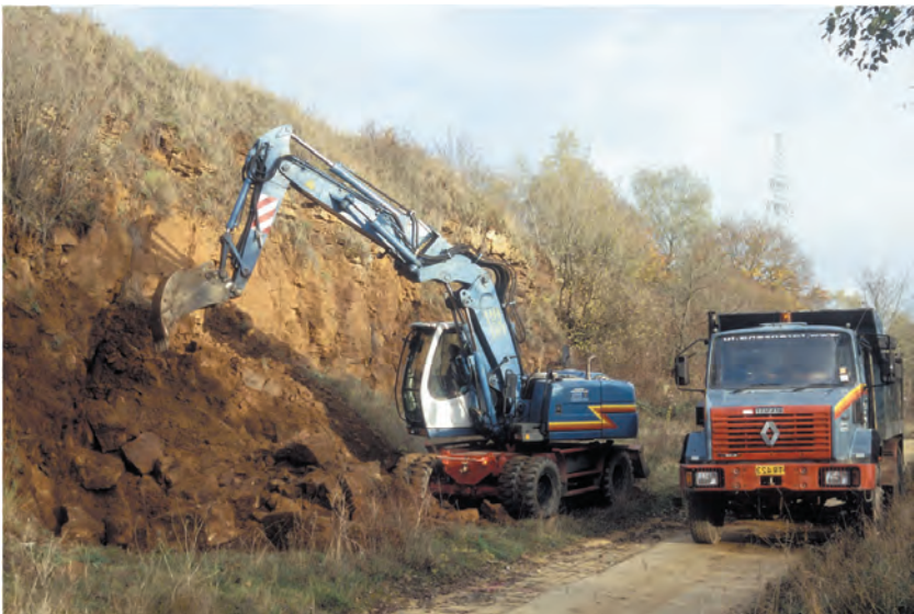
Abb. 4: Freistellungsarbeiten an Abbruchkante 2 (CUNGS 18.11.2005).
