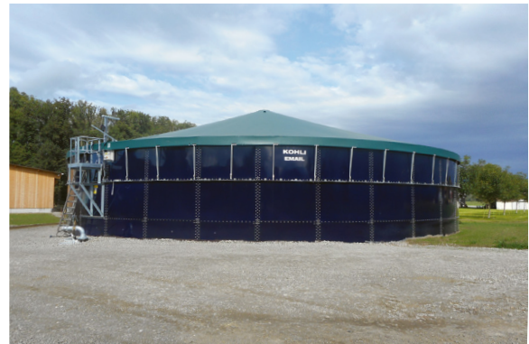
Güllelagerabdeckung mit Zeltdach (Quelle: H.U. Kohli AG)
